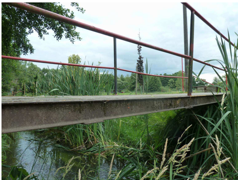
Ocelový nosník na vtoku bez PKO
